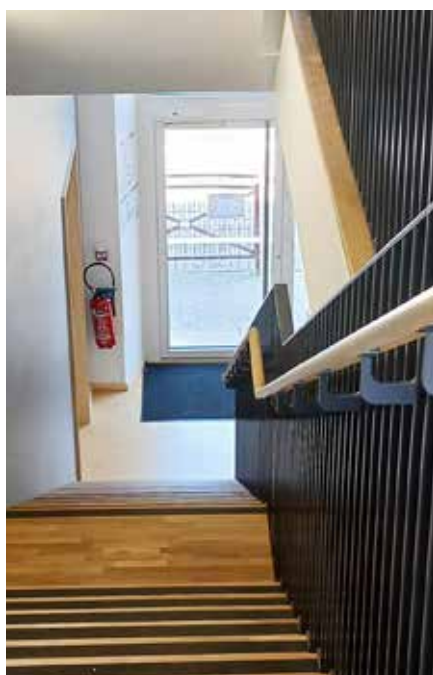
L'escalier a été modernisé.
