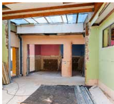
La charpente est en cours de réfection dans l'ancienne salle de motricité.
